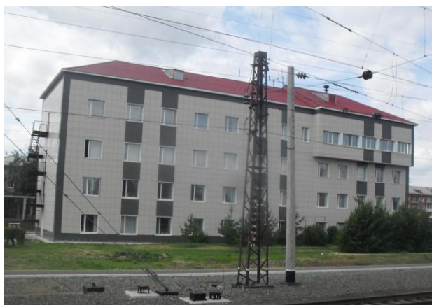
Рис. 1. Пост ЭЦ станции Омск-Пассажирский
