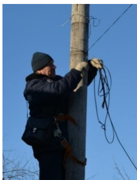
Рис. 1. Обслуживание воздушной линии связи
