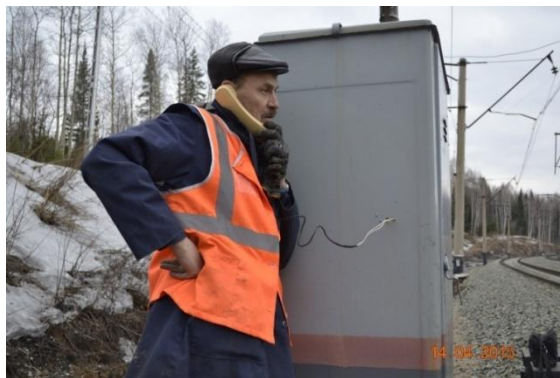
Рис. 1. Электромеханик связывается с ДСП ближайшей станции по ПГС
