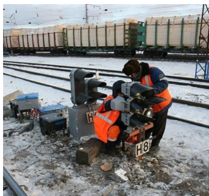
Рис.1. Обслуживание карликового светофора
