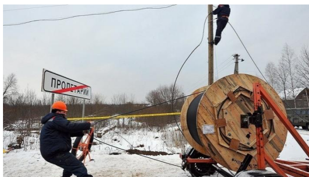
Рис. 2. Прокладка кабельной линии
