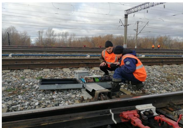
Рис 1. Электромонтеры выполняют работы по обслуживанию стрелочного электропривода
